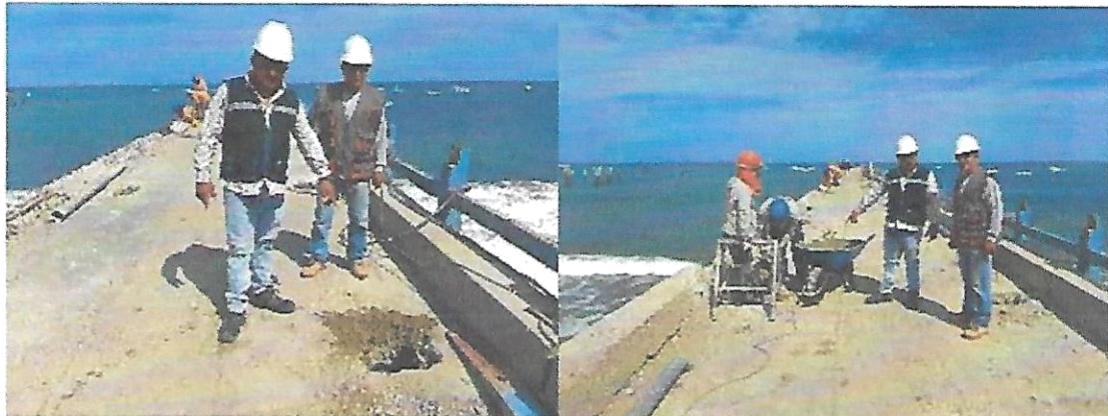
VACEADO DE CONCRETO PARA PILOTES
