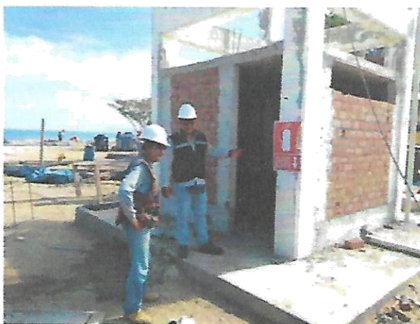
ASENTADO DE MURO EN SOGA EN CASETA DE VIGILANCIA
