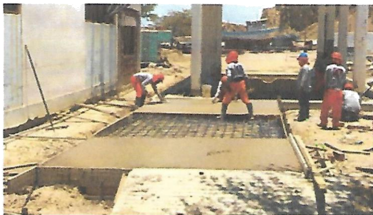
ACERO, ENCOFRADO Y CONCRETO DE LOSA EN PATIO DE MANIOBRAS
