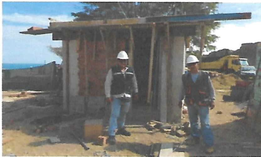
DEENCOFRADO DE LOSA ALIGERADA DE CASETA DE AGUA
