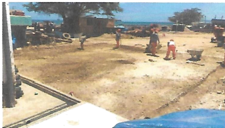
RELLENO Y COMPACTADO DE AFIRMADO EN PATIO DE MANIOBRAS
