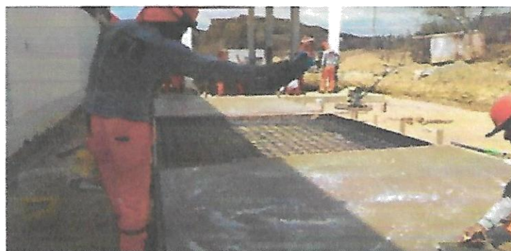
CURADO DE LOSA DE PATIO DE MANIOBRAS
