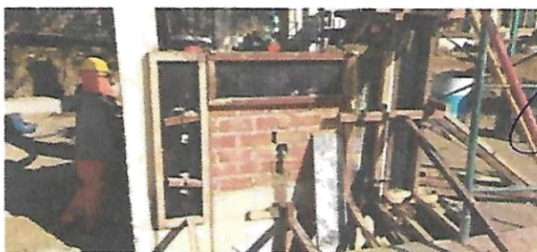
ENCOFRADO Y VACEADO DE CONCRETO DE VIGUETAS EN CASETA
