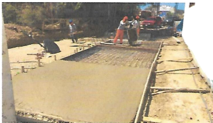
ACERO, ENCOFRADO Y CONCRETO DE LOSA EN PATIO DE MANIOBRAS
