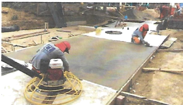
PULIDO DE LOSA DE PATIO DE MANIOBRAS
