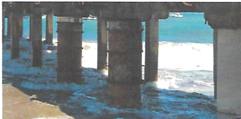
ENCAMISADO DE PILOTES
