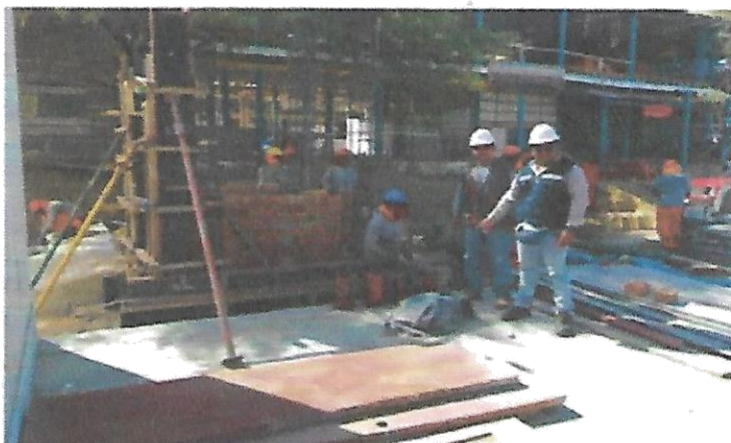
ASENTADO DE MURO EN SOGA EN CASETA DE VIGILANCIA
