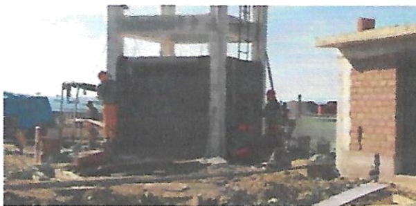
TARRAJEO INTERIOR E EXTERIOR DE DEPOSITO
