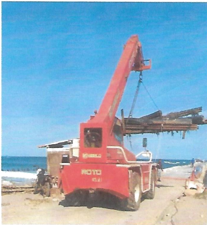
DESMONTAJE DE DEFENSAS Y LARGUEROS EN MUELLE
